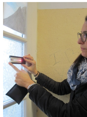
Figura 4.4 - Particolare dei serramenti.
