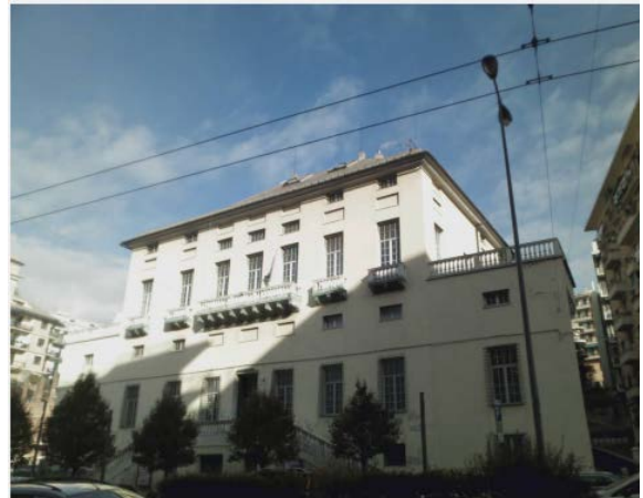
Figura 1.1 - Vista della facciata [esposta a Sud-Ovest]
