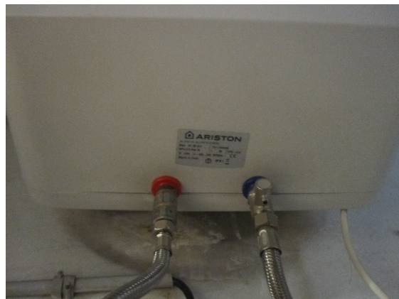
Figura 4.10 - Particolare di un boiler elettrico per la produzione di acqua calda sanitaria
