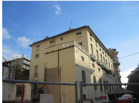
Figura 4.1 - Particolare della porzione di involucro storico.
