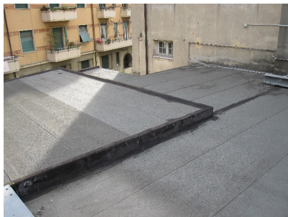
Figura 8.4 - Particolare copertura su cui intervenire.
