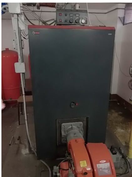
Figura 8.6 – Sostituzione generatore con Caldaia condensazione e valvole termostatiche
